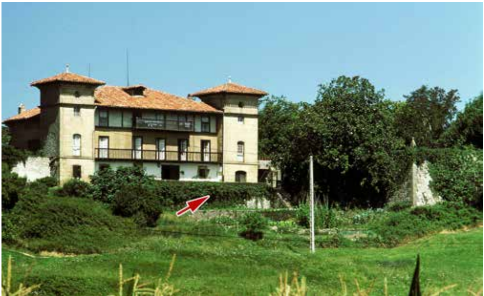
6 Imagen hacia 1985 80 (Fot. DFG/GFA dirección general de Cultura) La flecha señala el muro que fue aspillerado frente al palacio.
