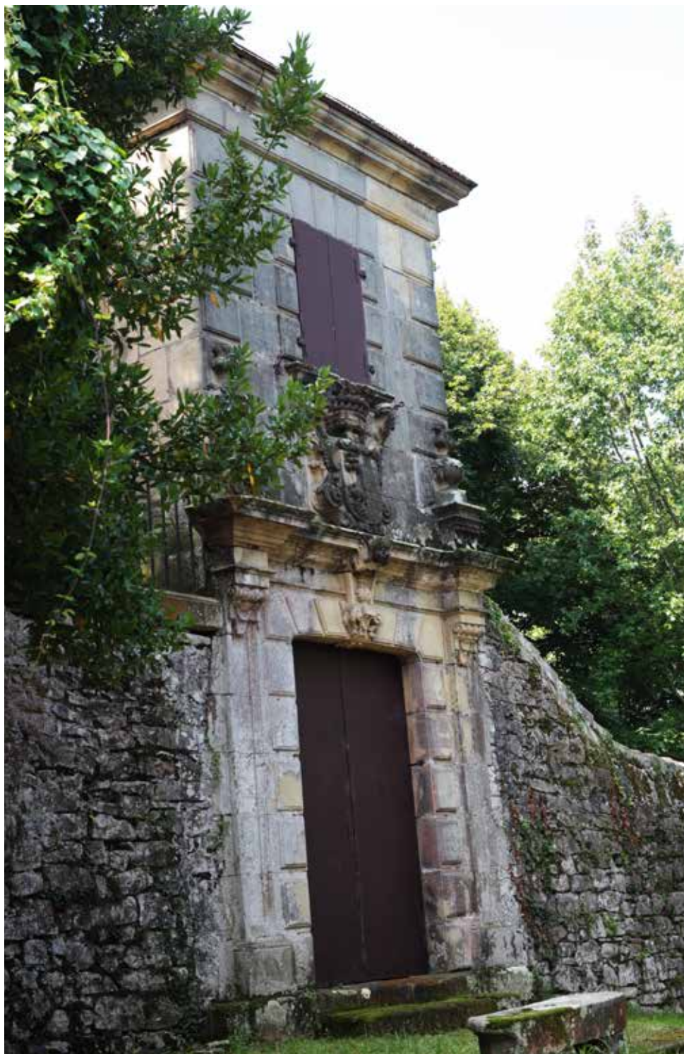
Acceso al Jardín. Al parecer fue construido un tambor aspillero partiendo de la puerta.
