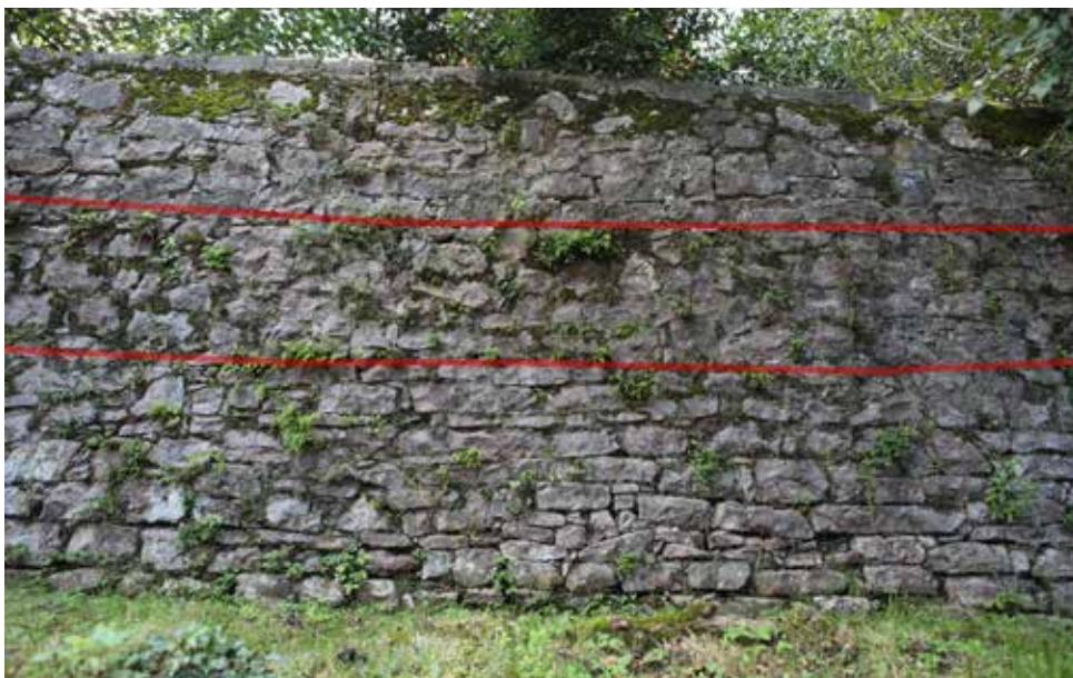
Muro de cierre del jardín. No consta que fuera aspillerado durante la última guerra carlista, pero se observa una irregularidad sostenida en el aparejo del centro del muro, de origen desconocido. No se observan aspilleras cegadas. No obstante hay noticias que en 1918 se conservaban aspilleras en el muro del jardín (véase anexo).
