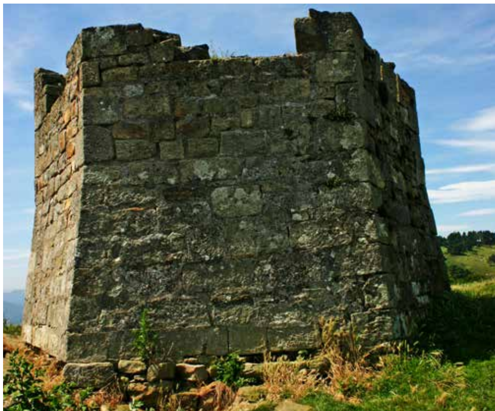
Caras orientales del torreón. Se aprecia el ligero talud de las paredes exteriores en su planta inferior.
