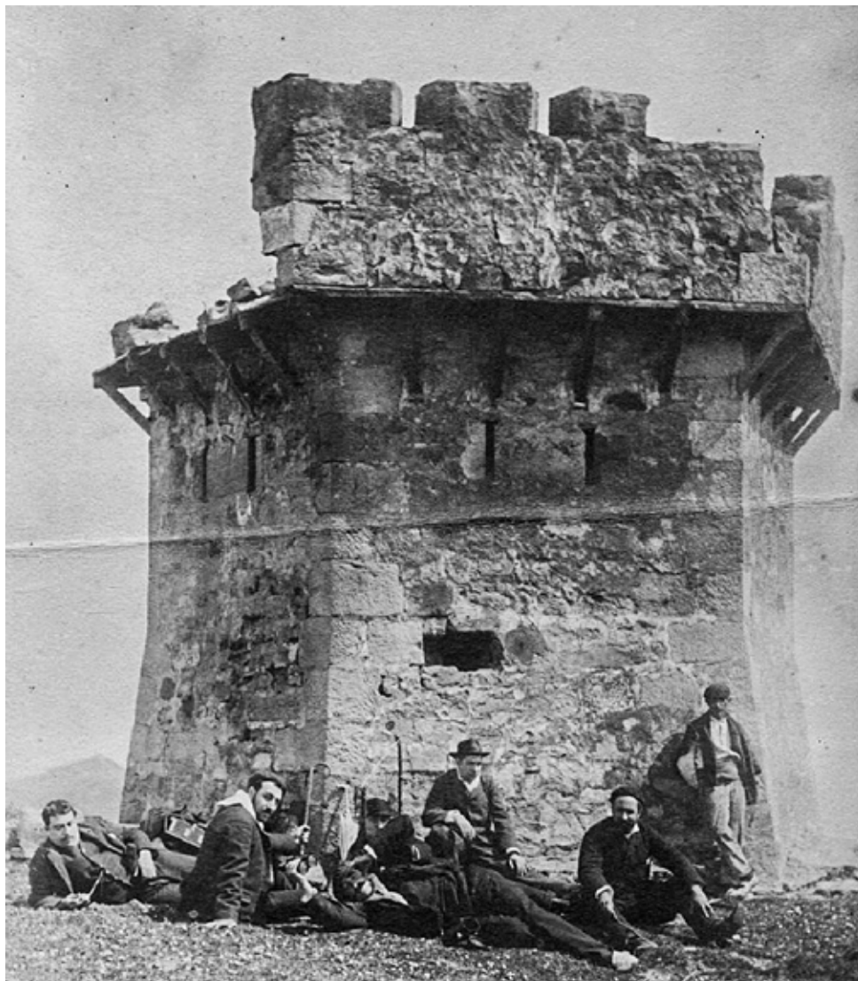
Torre de Santa Barbara hacia principios del siglo XX, todavía en relativo buen estado con la estructura de madera sosteniendo el aspillero superior y causa de la ruina del mismo. Kutxa Fototeka. Fondo Munoa. Fotógrafo Santesteban. CCbySA.
