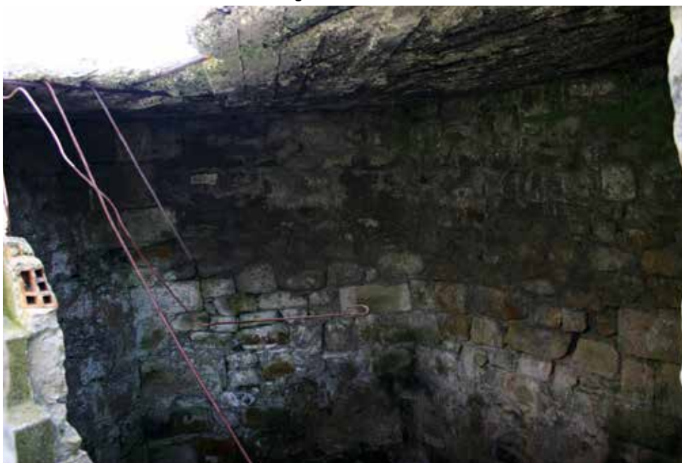
2 Interior del torreón. Se parecía un forjado de hormigón armado apoyado en el muro perimetral. También se observa que la escalera interior está confeccionada mediante ladrillo no excesivamente antiguo
