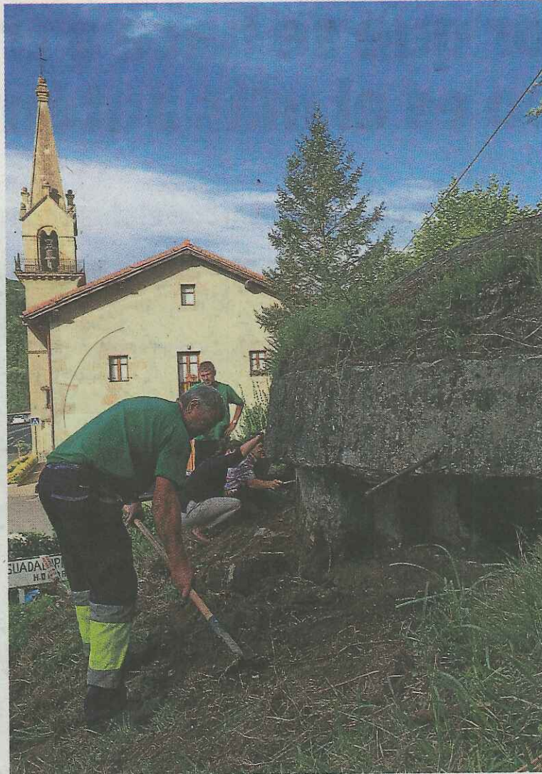
Operarios trabajando en uno de los búnkeres de Guadalupe.
