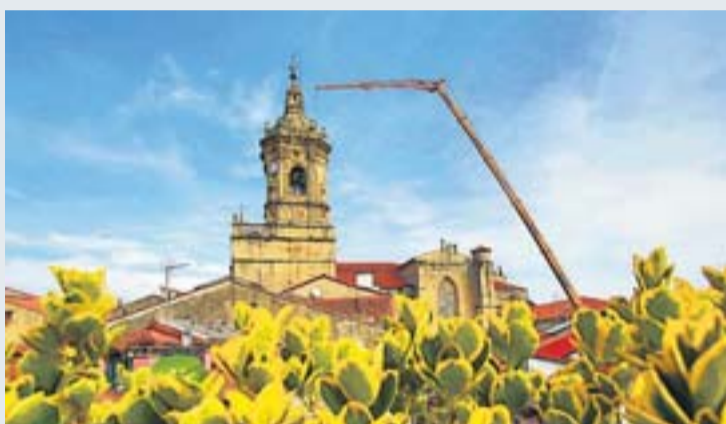
La grúa superó la altura del campanario en la operación.
