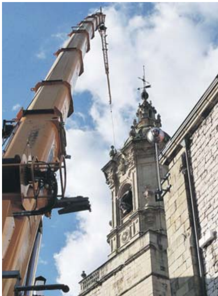
Operación. Se empleó una grúa de grandes dimensiones. :: I.N.
